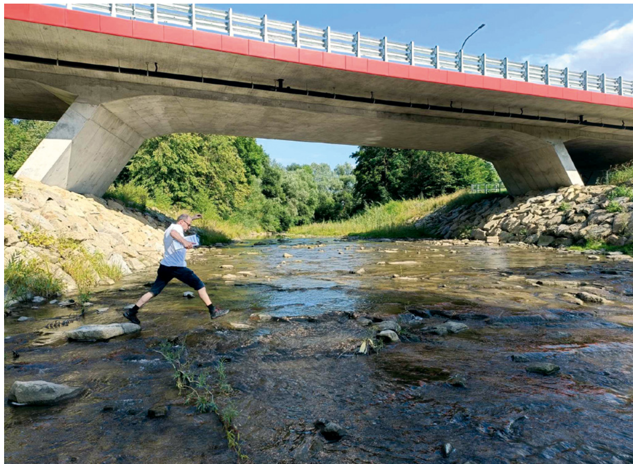
Fot. 6. Most na Sękówce wraz z lokalnymi umocnieniami brzegu oraz koryta. Fot. A. Pawelec
