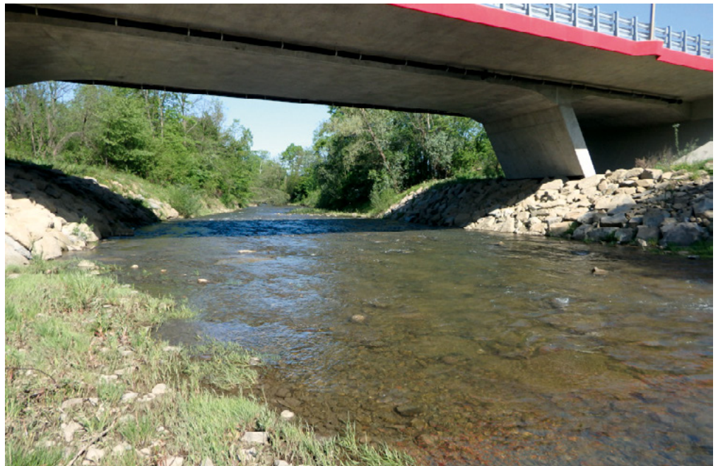
Fot. 5. Kamienne zabezpieczenia brzegów. Fot. P. Guzik
